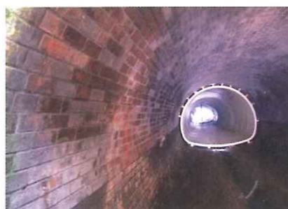
Oben: Fixierung der Rohrstücke vor dem Verdämmen
