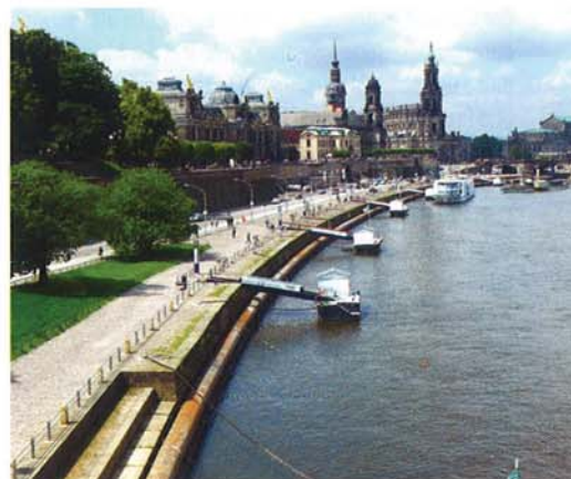
Abbildung 1: Der Altstädter Abfangkanal verläuft unter dem Terrassenufer, dem Schloss- und Theaterplatz, der Semperoper und der Devrientstraße, er ist einer der wichtigsten Abwasserkanäle Dresdens
