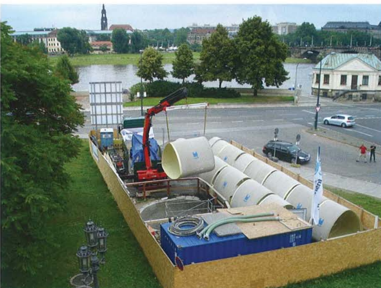
Abbildung 5: Von der Einbaugrube wurden die Elemente Stück für Stück eingehoben
